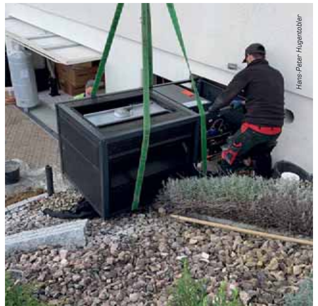
Ein Kran schiebt die Heizung durch ein Loch in der Fassade.
